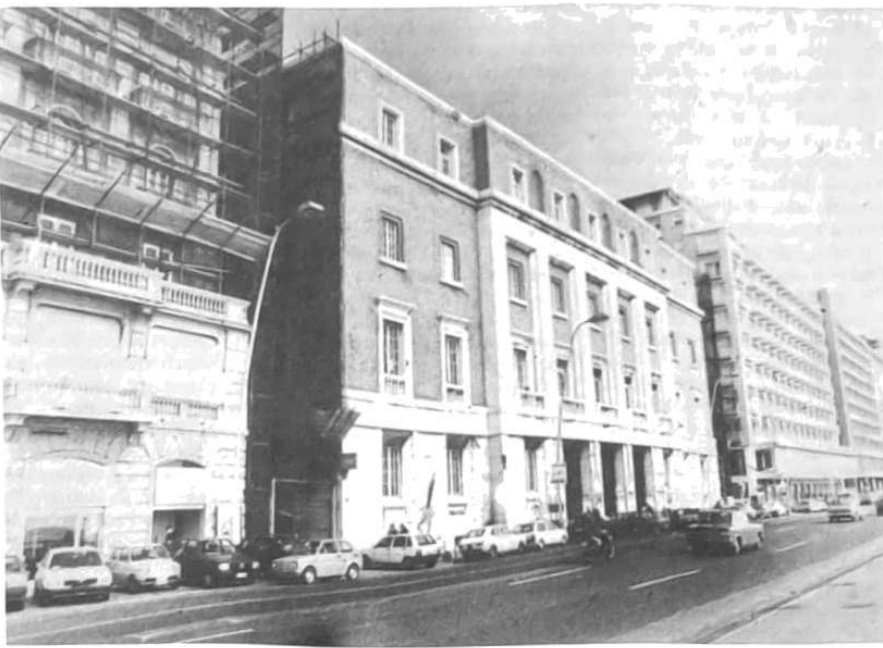
Esterni della Facoltà di Via Partenope
