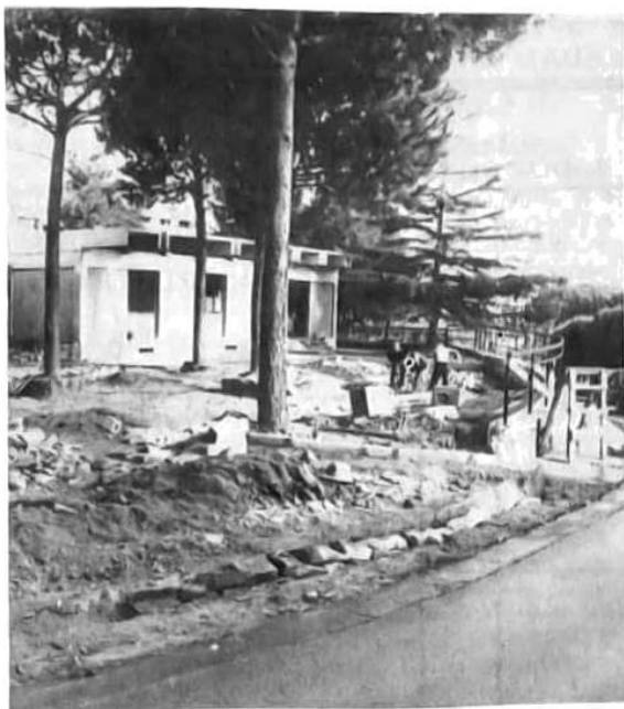
Cantiere a Medicina II
