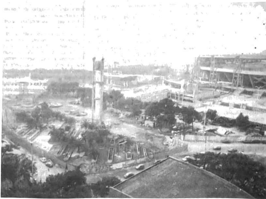
I lavori a Piazzale Tecchio, davanti la Facoltà di Ingegneria
