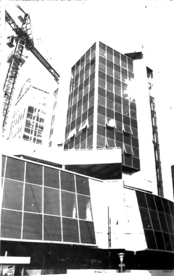
La nuova sede di Giurisprudenza, in via Marittima, ormai ultimata
