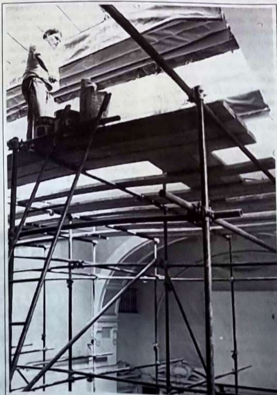
Lavori in corso nell'Aula Vanvitelliana
