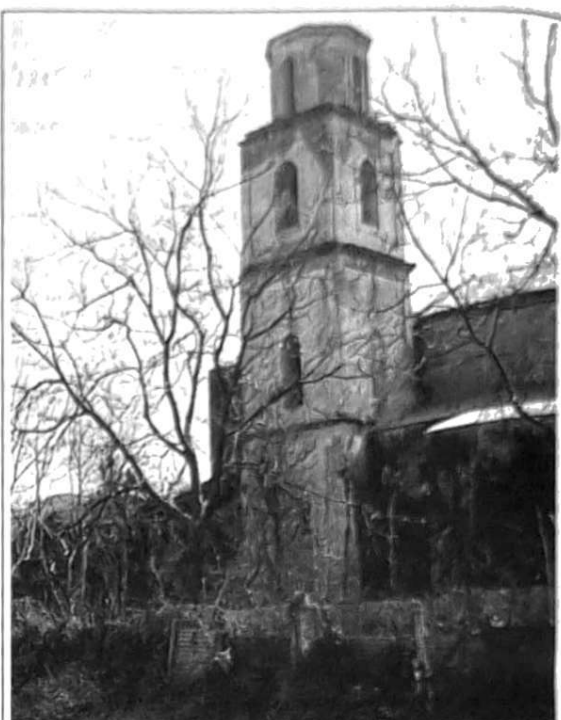
Architettura. Complesso di S. Lorenzo
