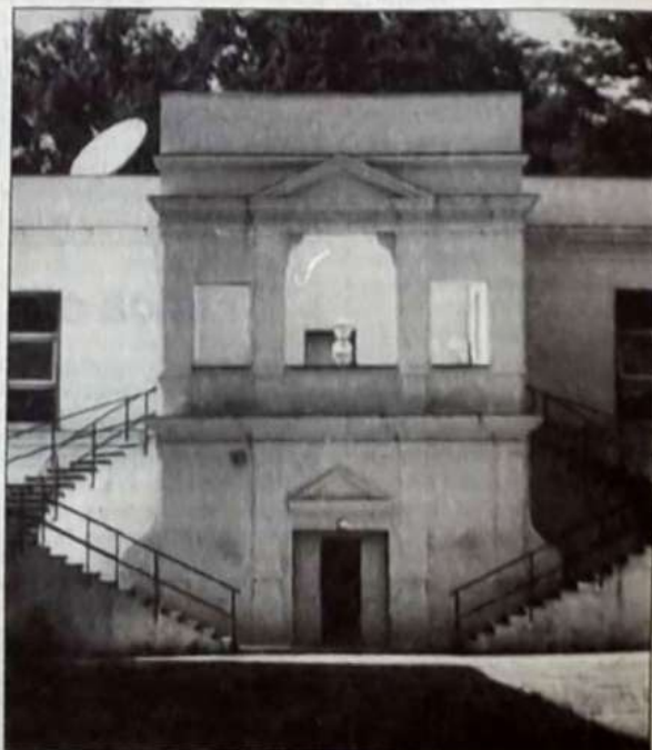
Aula Polifunzionale dell'Edisu. E' chiusa da anni per problemi strutturali
