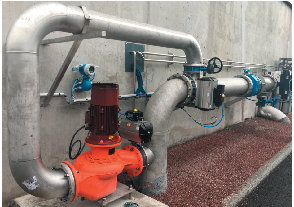
Figura 8. Bomba como turbina en planta piloto REDAWN
